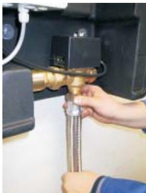
**!** Faites attention à l'étanchéité des connexions sur la ligne d'alimentation ! Utilisez uniquement des matériaux agréés pour le fonctionnement en dépression, en particulier pour un raccordement de tuyau flexible!
